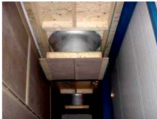
Камера смешивания с антивозвратными клапанами
